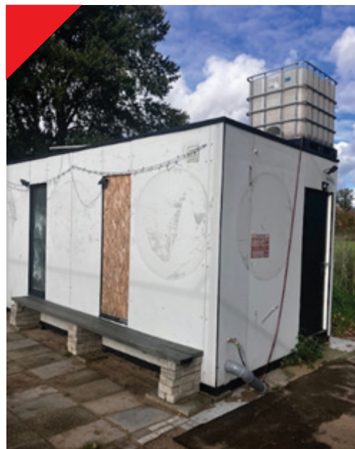
Afbeelding 2: Clubgebouw. Deze tweedehands keet fungeert als clubgebouw Dynamics. Op het dak een vat met "grijs" water uit een hemelwaterriool, bedoeld om het toilet door te kunnen spoelen. Drinkwater wordt gehaald uit een openbaar watertappunt op > 100 meter van het gebouw.
