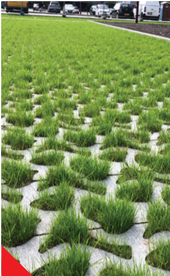
Afbeelding 21: Parkeerplaats met grasbetontegels
