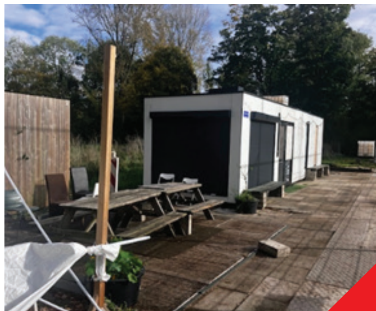
Afbeelding 2: Clubgebouw. Deze tweedehands keet fungeert als clubgebouw Dynamics. Op het dak een vat met "grijs" water uit een hemelwaterriool, bedoeld om het toilet door te kunnen spoelen. Drinkwater wordt gehaald uit een openbaar watertappunt op > 100 meter van het gebouw.
